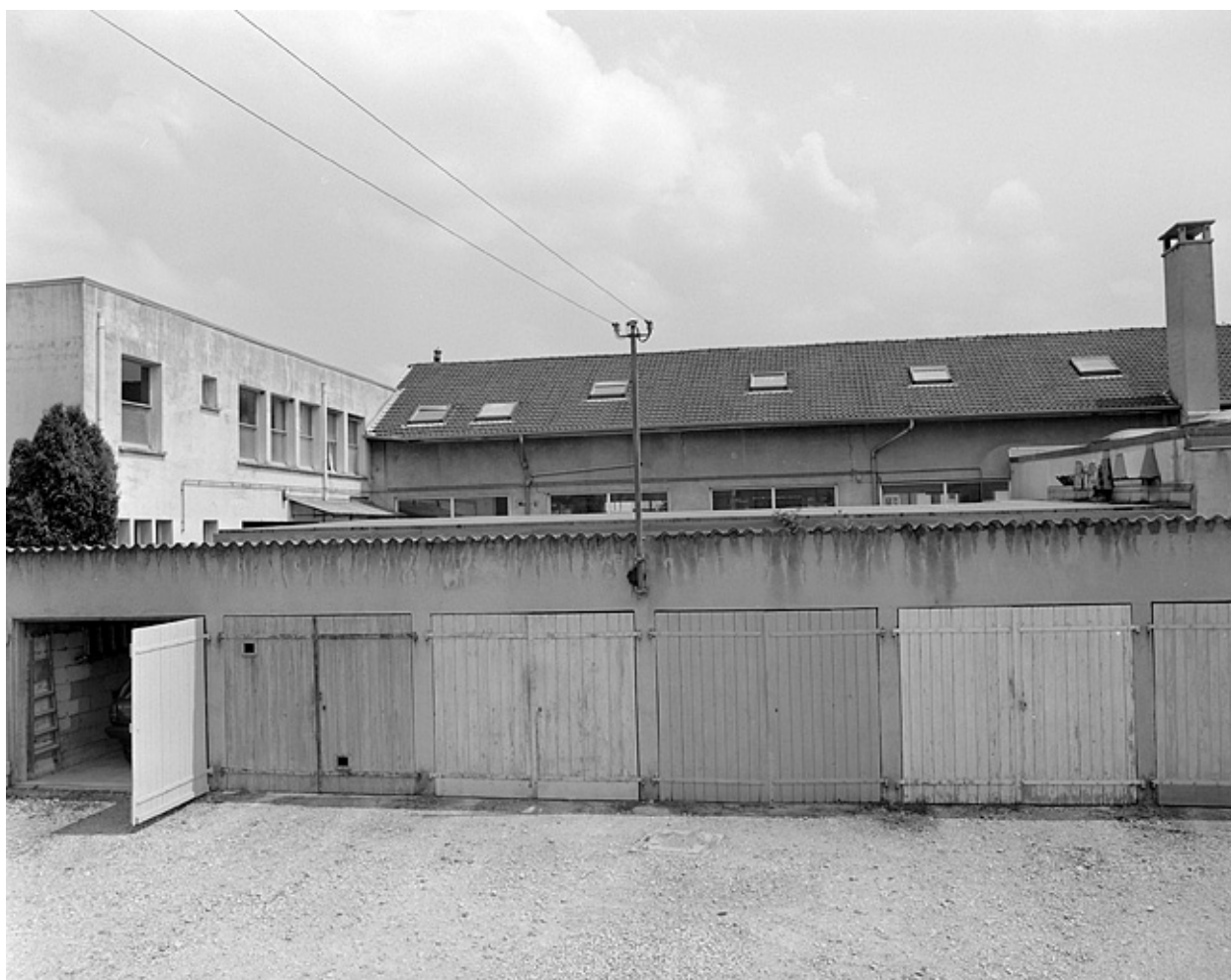
Bureau et atelier de fabrication depuis l'ouest.
