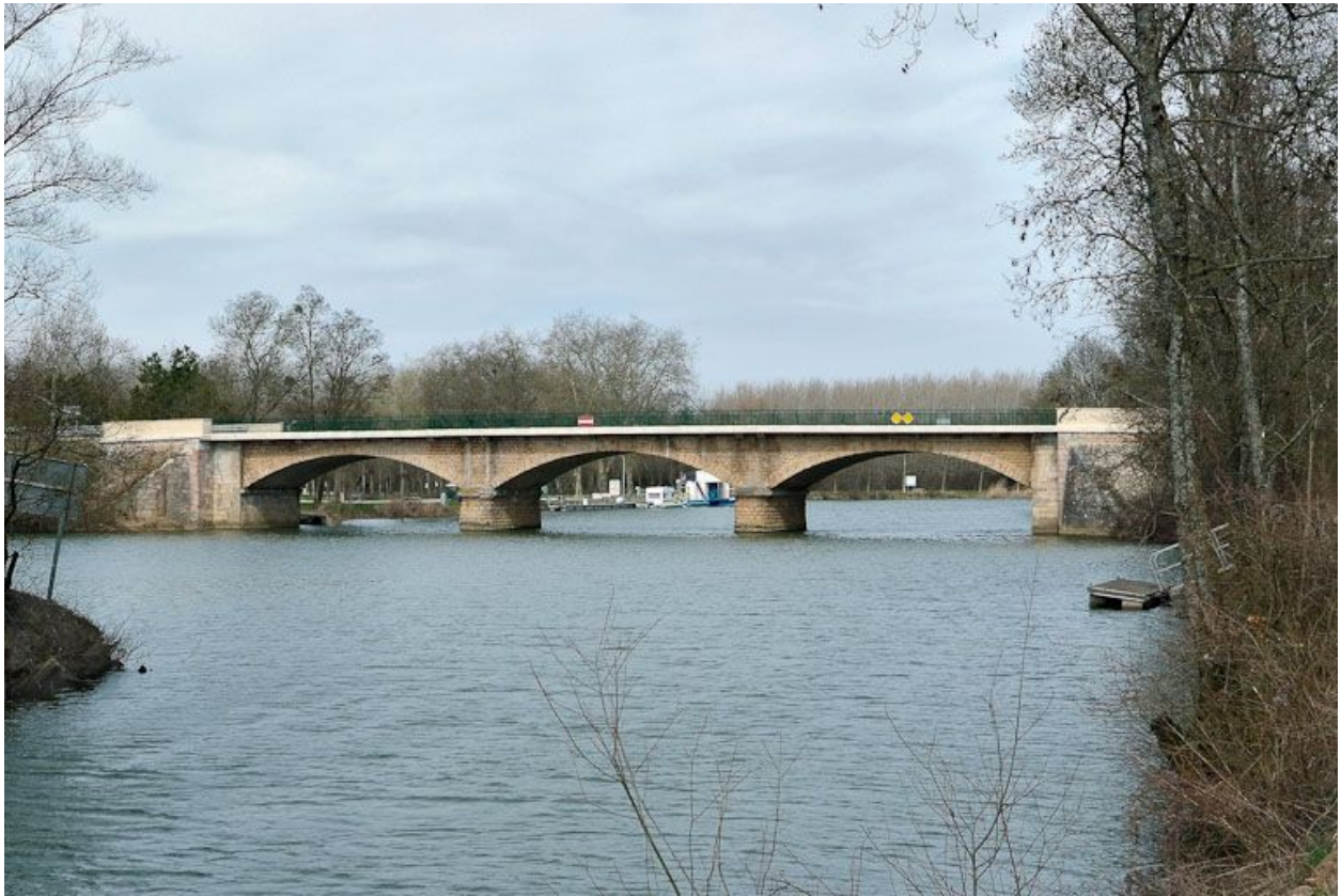
Le pont de Cuisery, vue d'amont.
