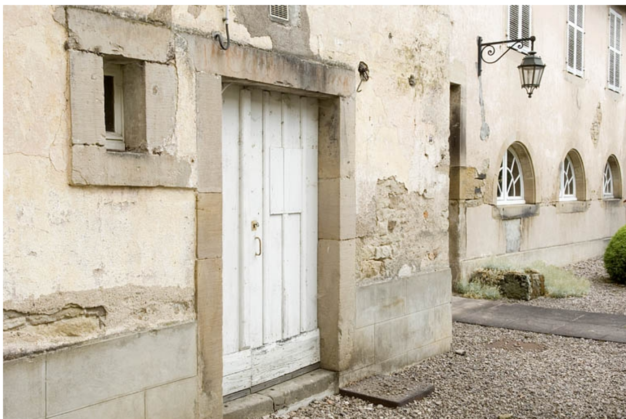
Détail de la façade de l'aile nord.
