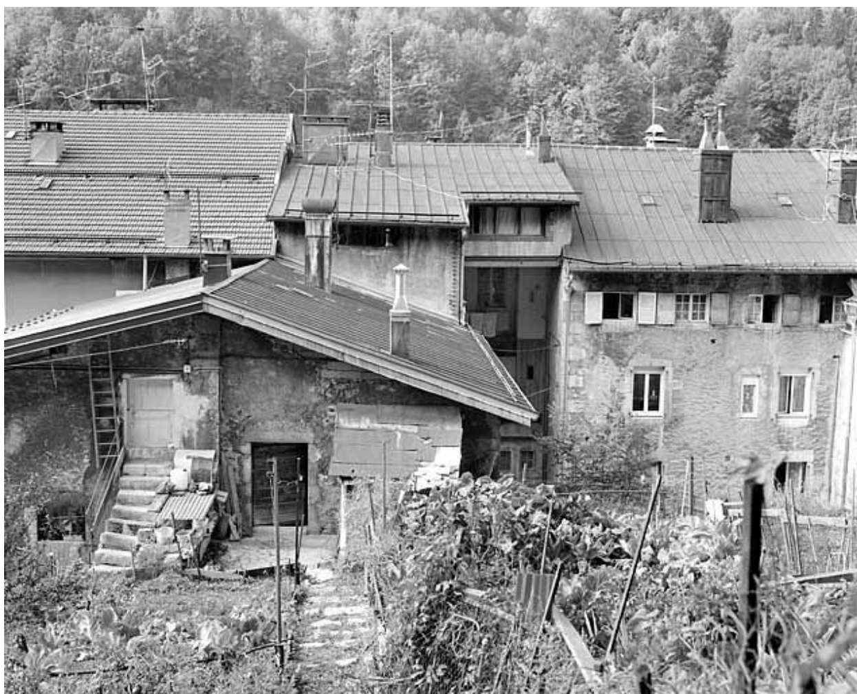
Ancien atelier : mur pignon oriental.
