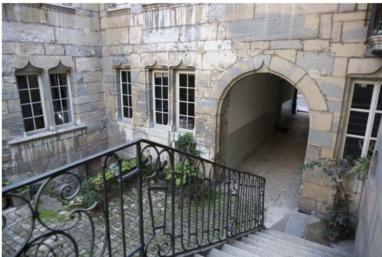
Détail du rez-de-chaussée sur cour depuis l'escalier.
