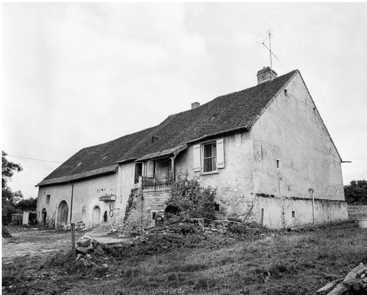
façade antérieure et face droite.
