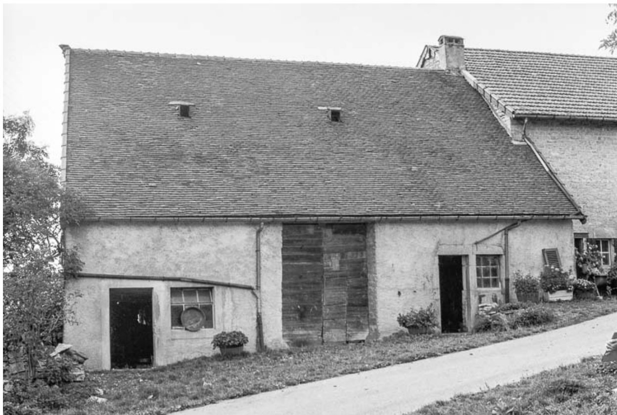
Ferme cadastrée A3 447 : façade antérieure.
