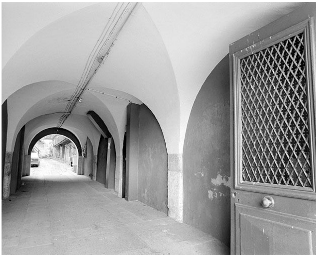
Passage couvert voûté.
