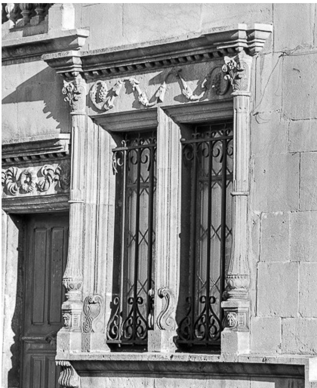
Façade sur cour, détail : fenêtre du rez-de-chaussée.
