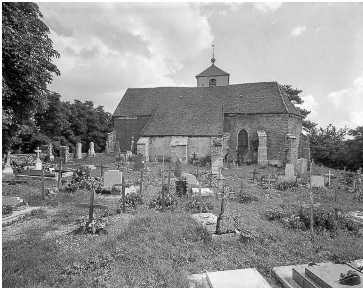
Façade latérale droite.
