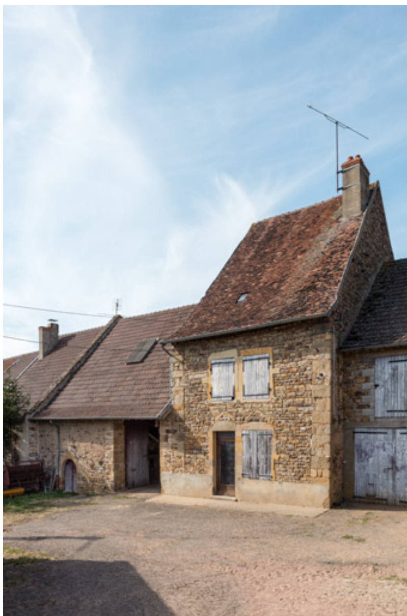
Vue de la ferme n°4 (A 379).
