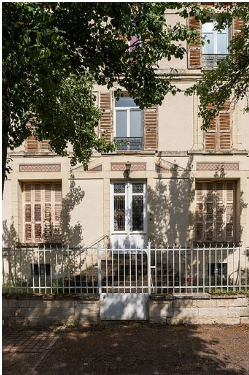
Façade ouest, détail avec la porte d'entrée.
