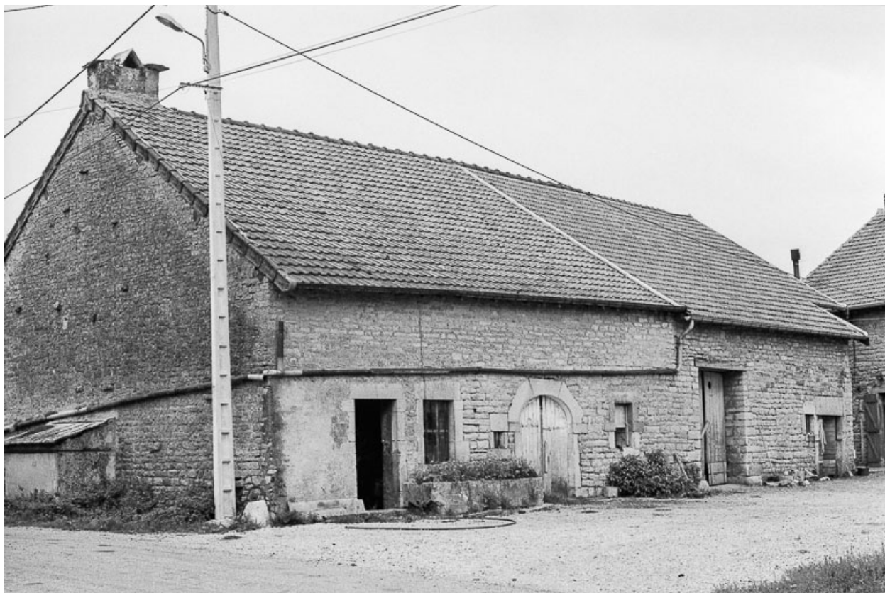
Ferme cadastrée B2 157 : façade sur rue.
