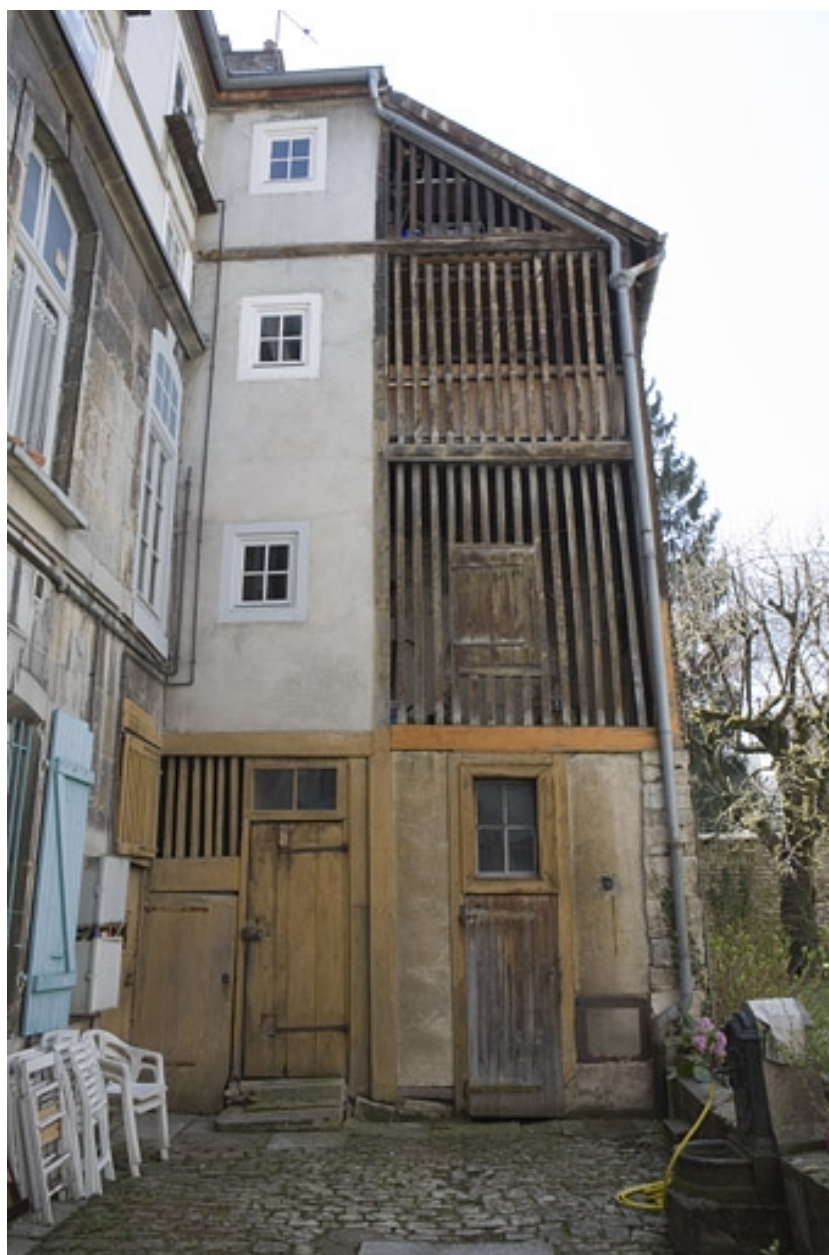
Détail de l'aile des bûchers sur jardin.
