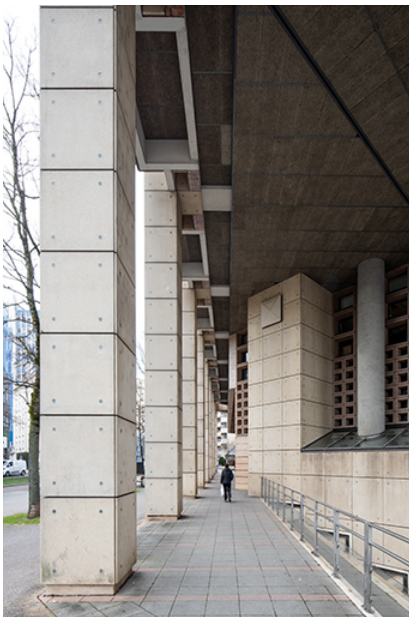
Façade sur l'avenue Georges-Clemenceau, détail : galerie en rez-de-chaussée.
