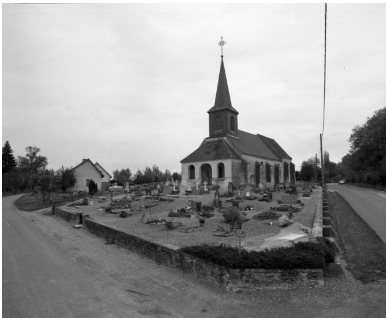
Vue d'ensemble, façade et élévation droite.
