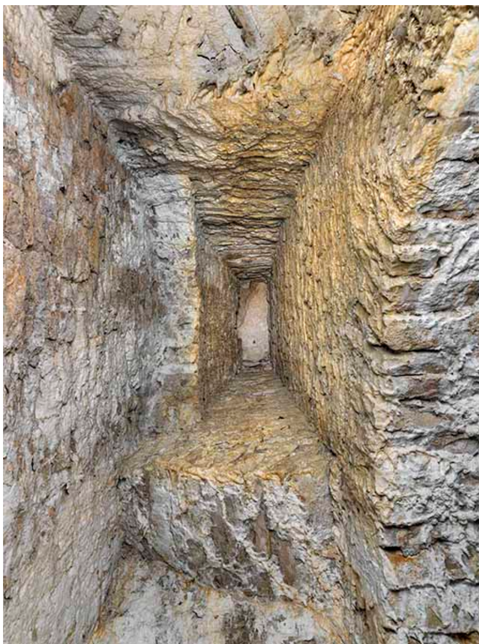
Hotte d'une cheminée.
