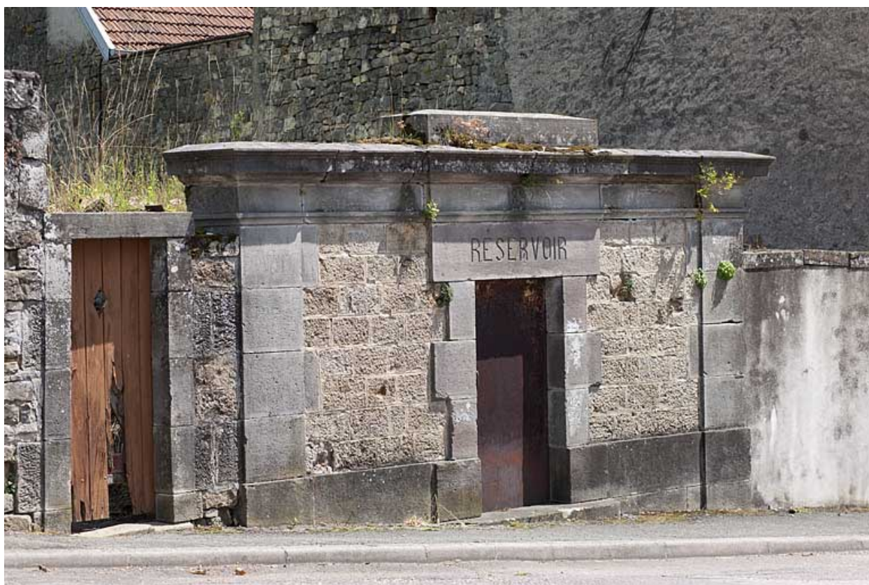
Le réservoir (AB 697), rue du Général Rébillot.
