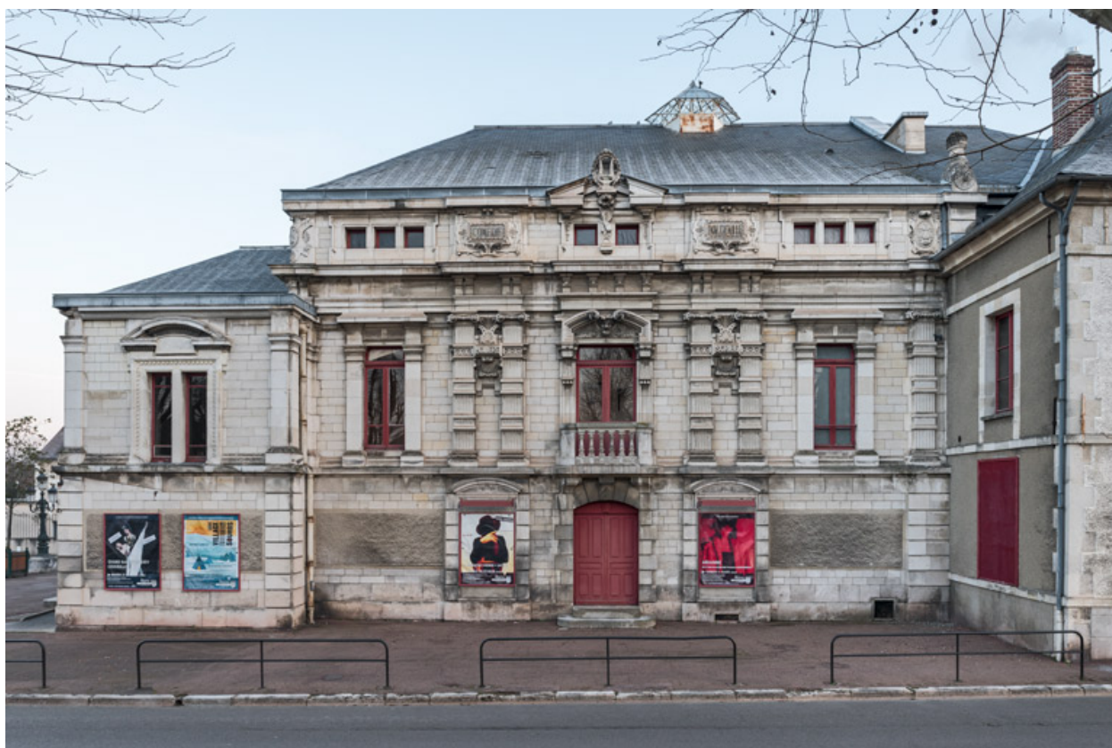
Façade latérale droite (côté cour).
