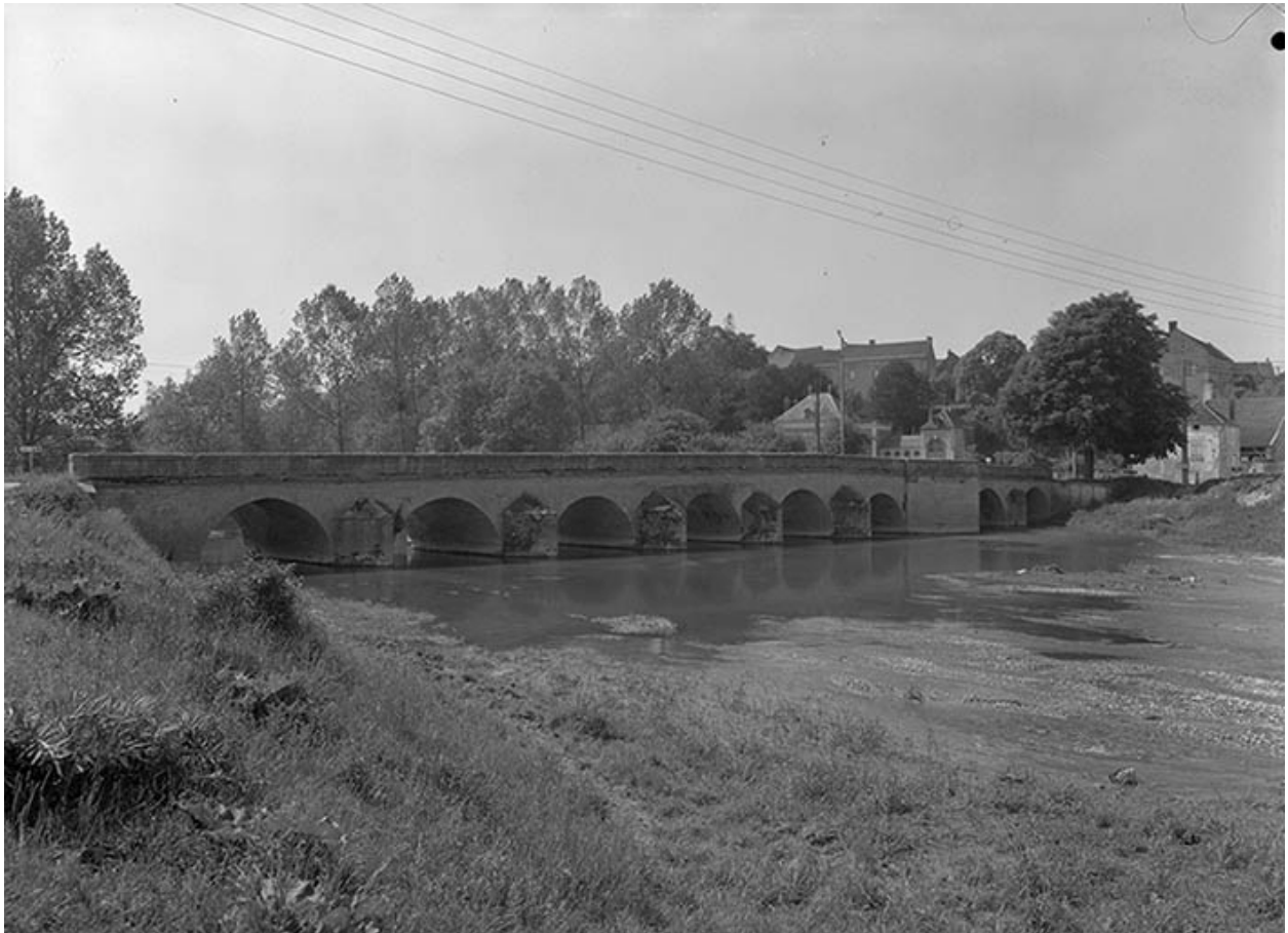
Pont sur l'Armançon (pont routier).
