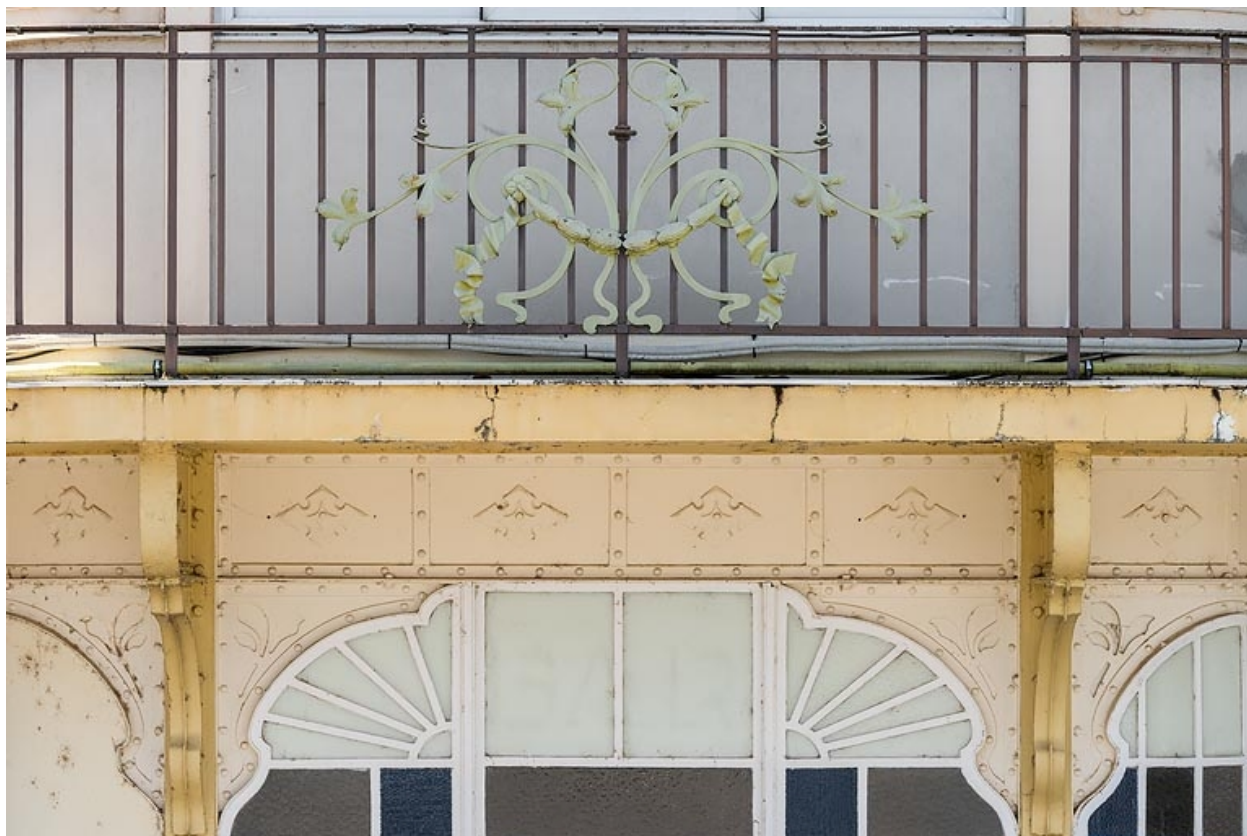
Aile ouest, salle à manger, détail.
