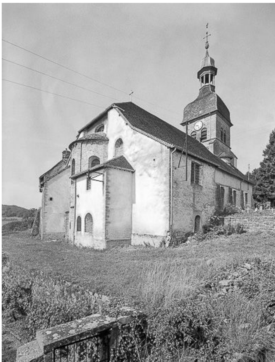
Eglise : façades postérieure et latérale gauche.
