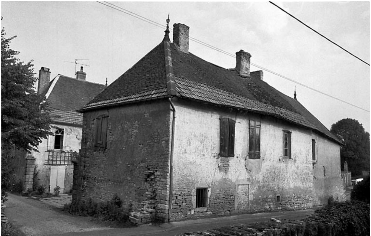
Façade sur rue de l'habitation droite.
