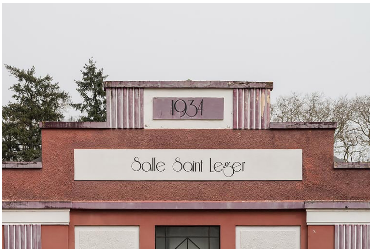
Façade, détail ("Salle Saint-Léger 1934").
