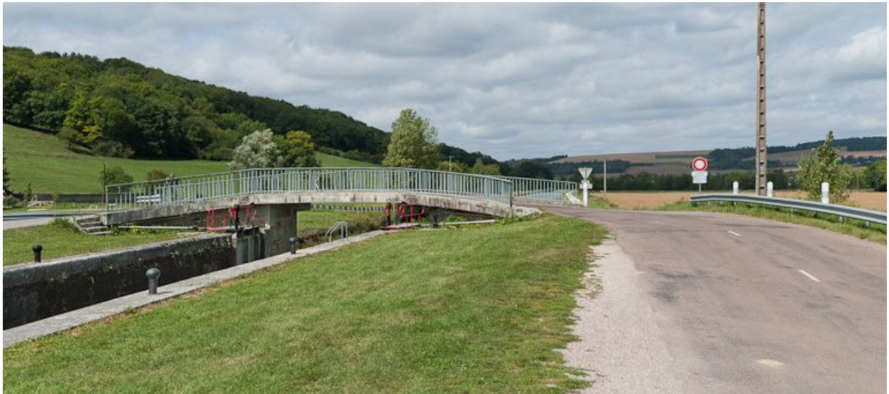
Vue du pont depuis l'amont.
