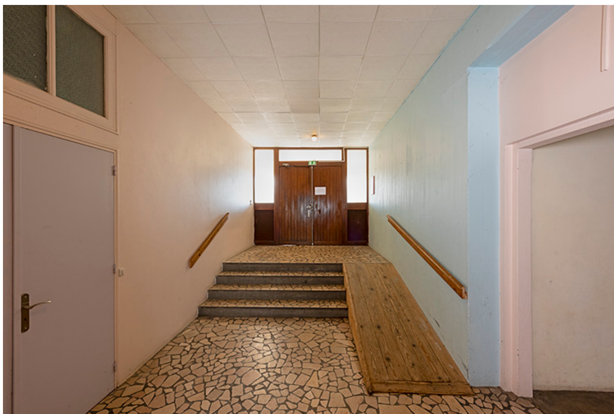
Etage de soubassement. Vue de l'entrée.
