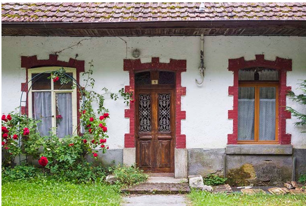
Logements d'ouvriers : façade antérieure du logement nord.
