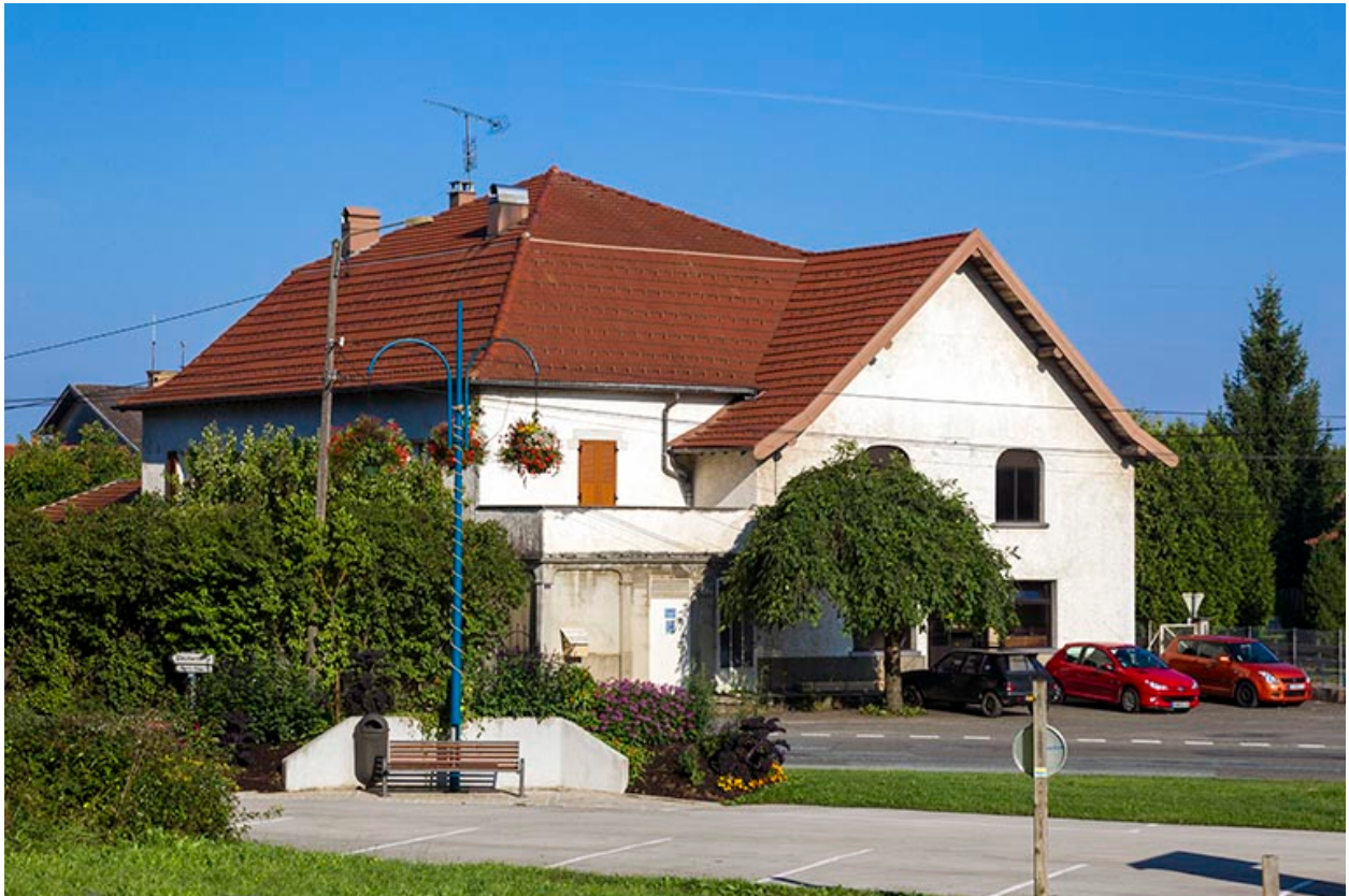
Vue d'ensemble du site, depuis l'est.
