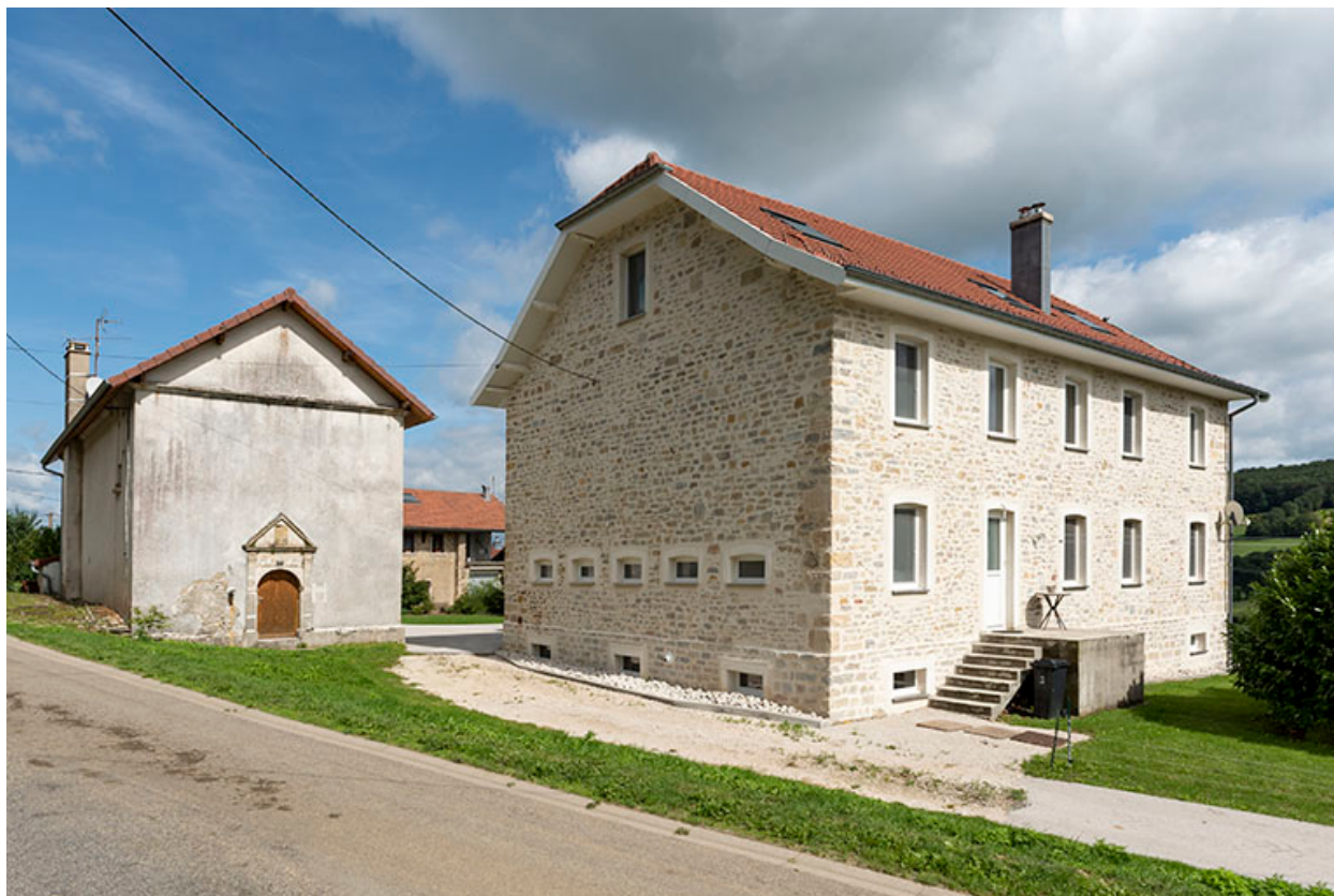
Façades postérieure et latérale droite.
