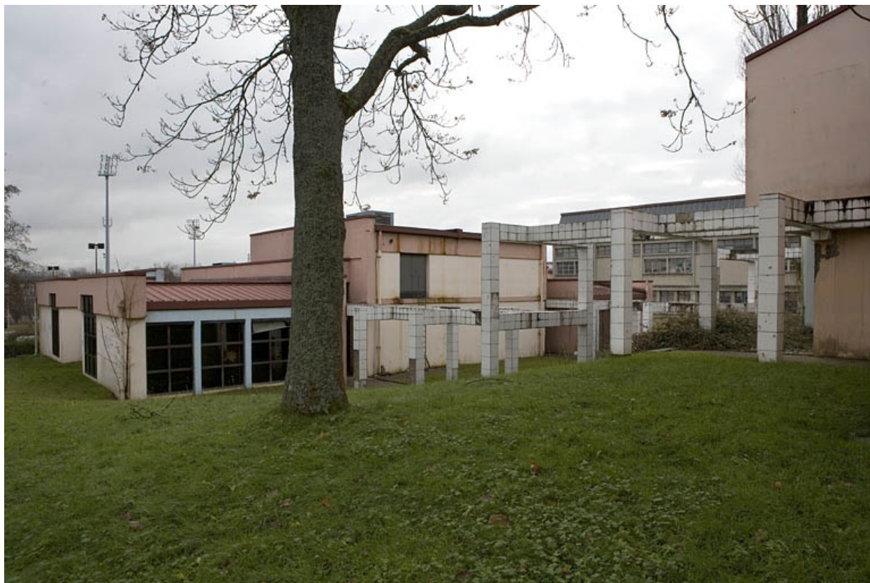
Vue de trois quarts gauche bâtiment J.
