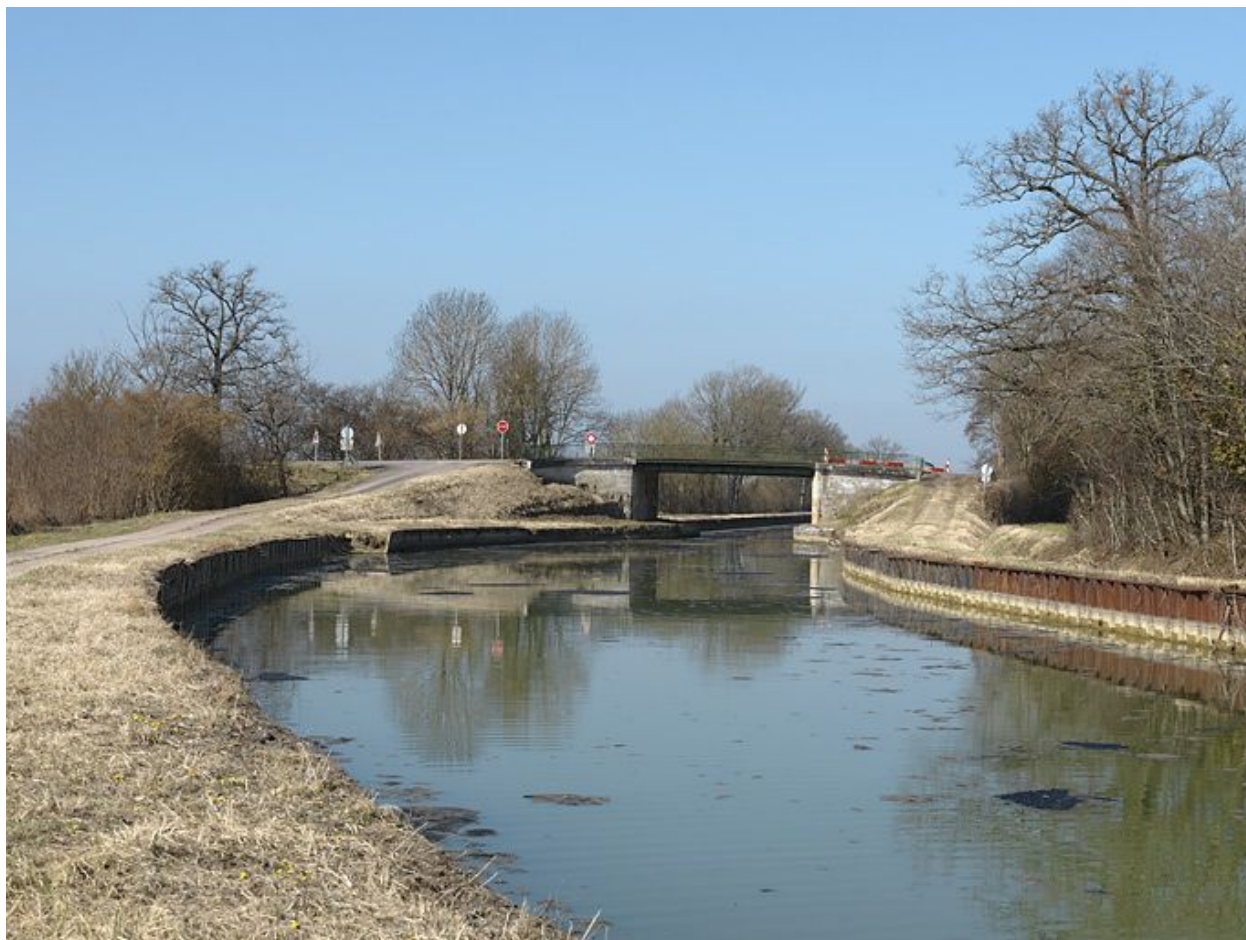
Vue d'ensemble du pont.
