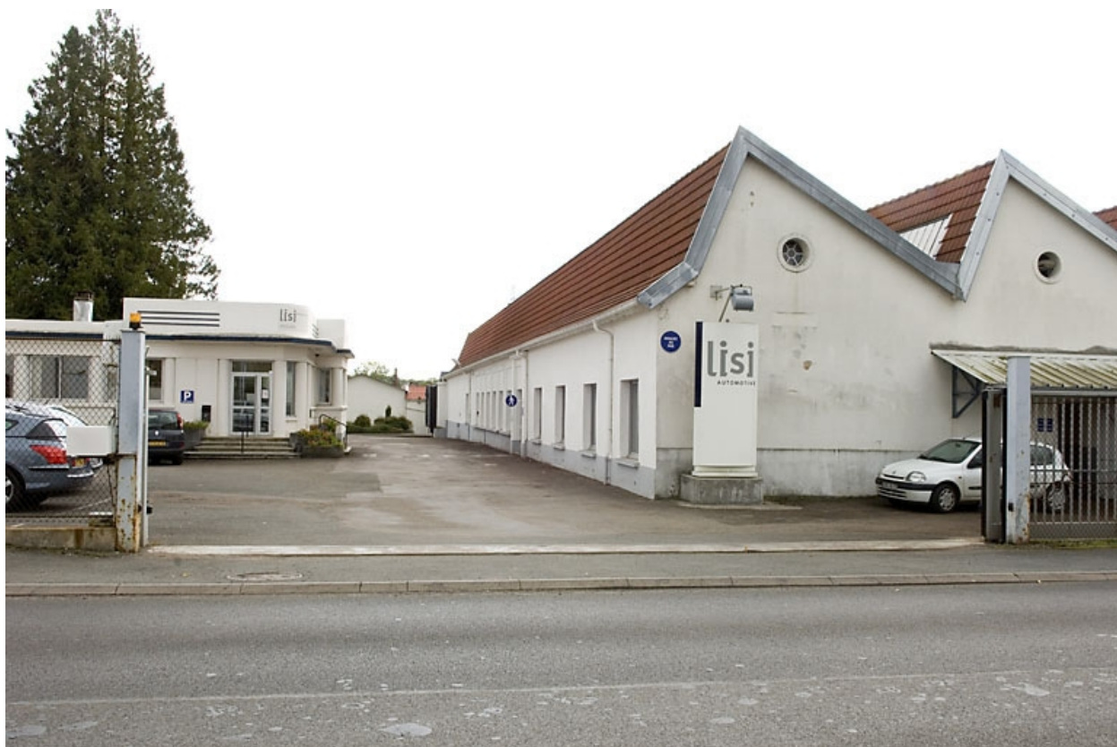
Entrée de l'usine.
