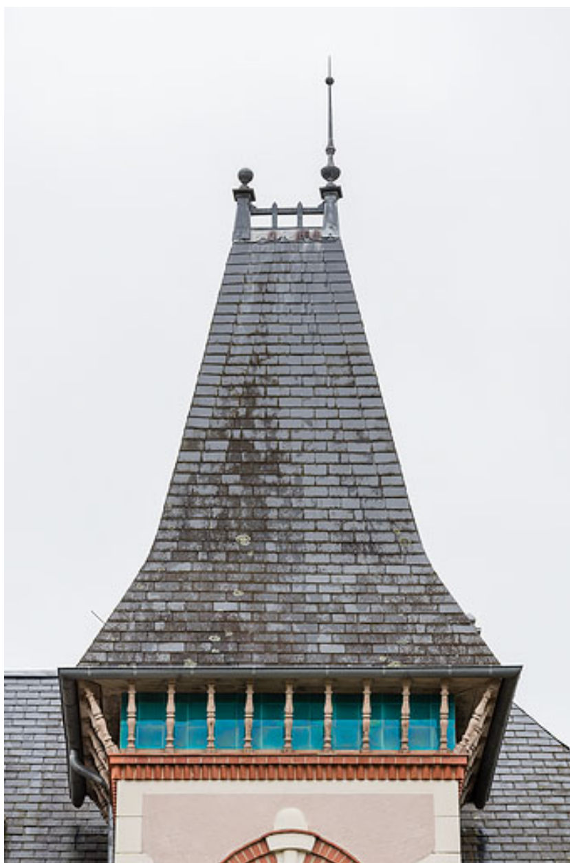
Tour demi-hors-œuvre, toiture et crête faîtière.
