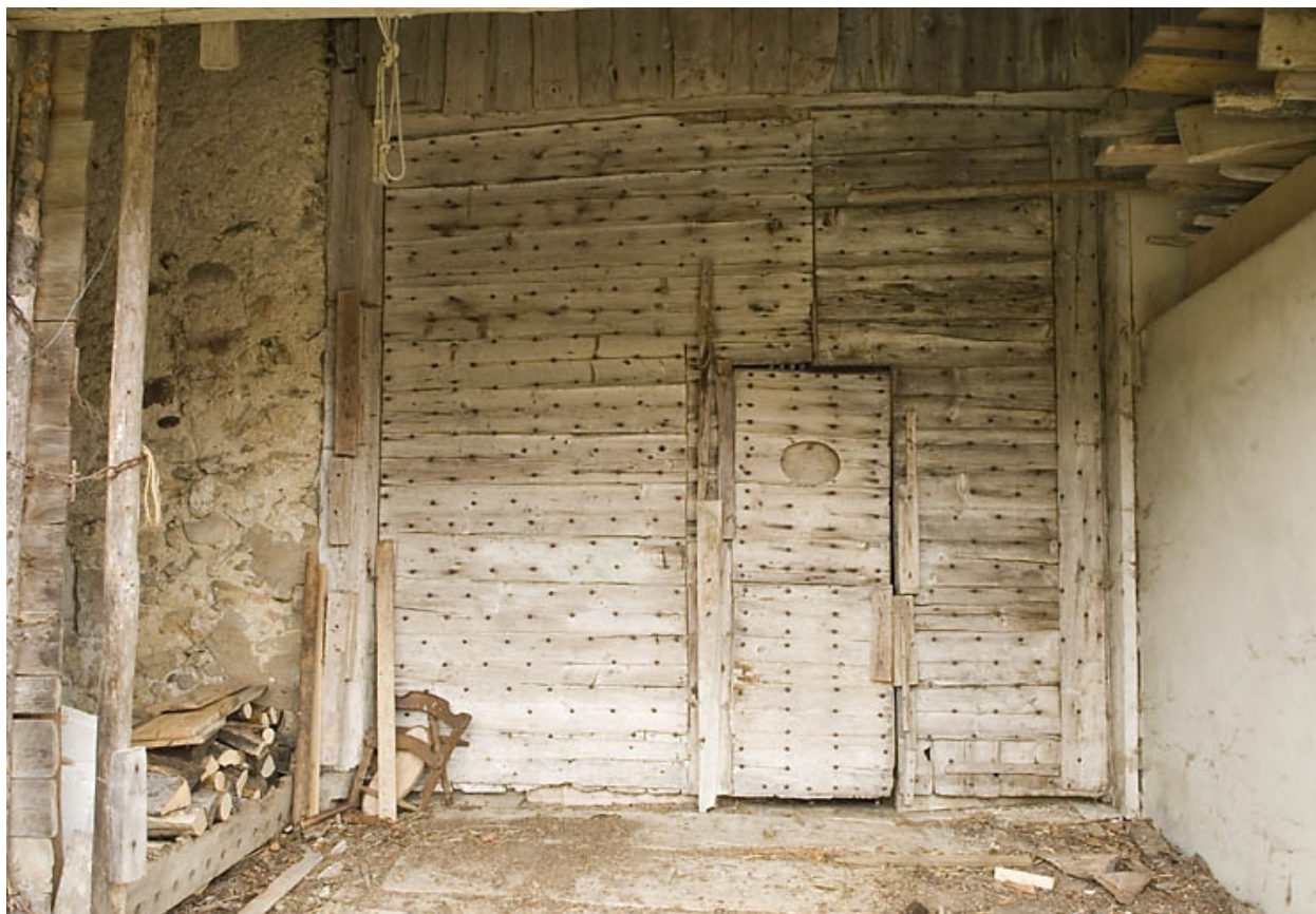
Façade postérieure : porte de la grange.
