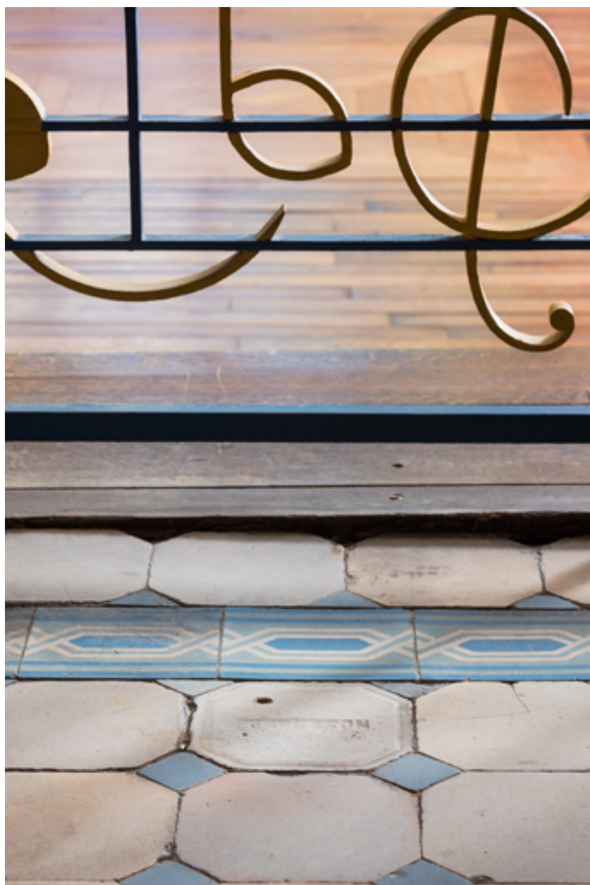
Salle de bal : sol de l'ancienne buvette.
