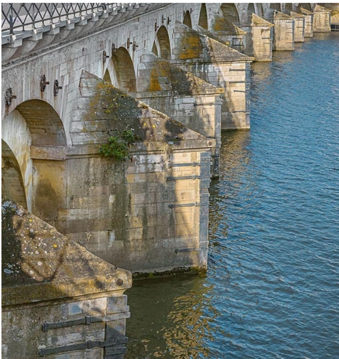
Les avant-becs du pont Saint-Laurent.
