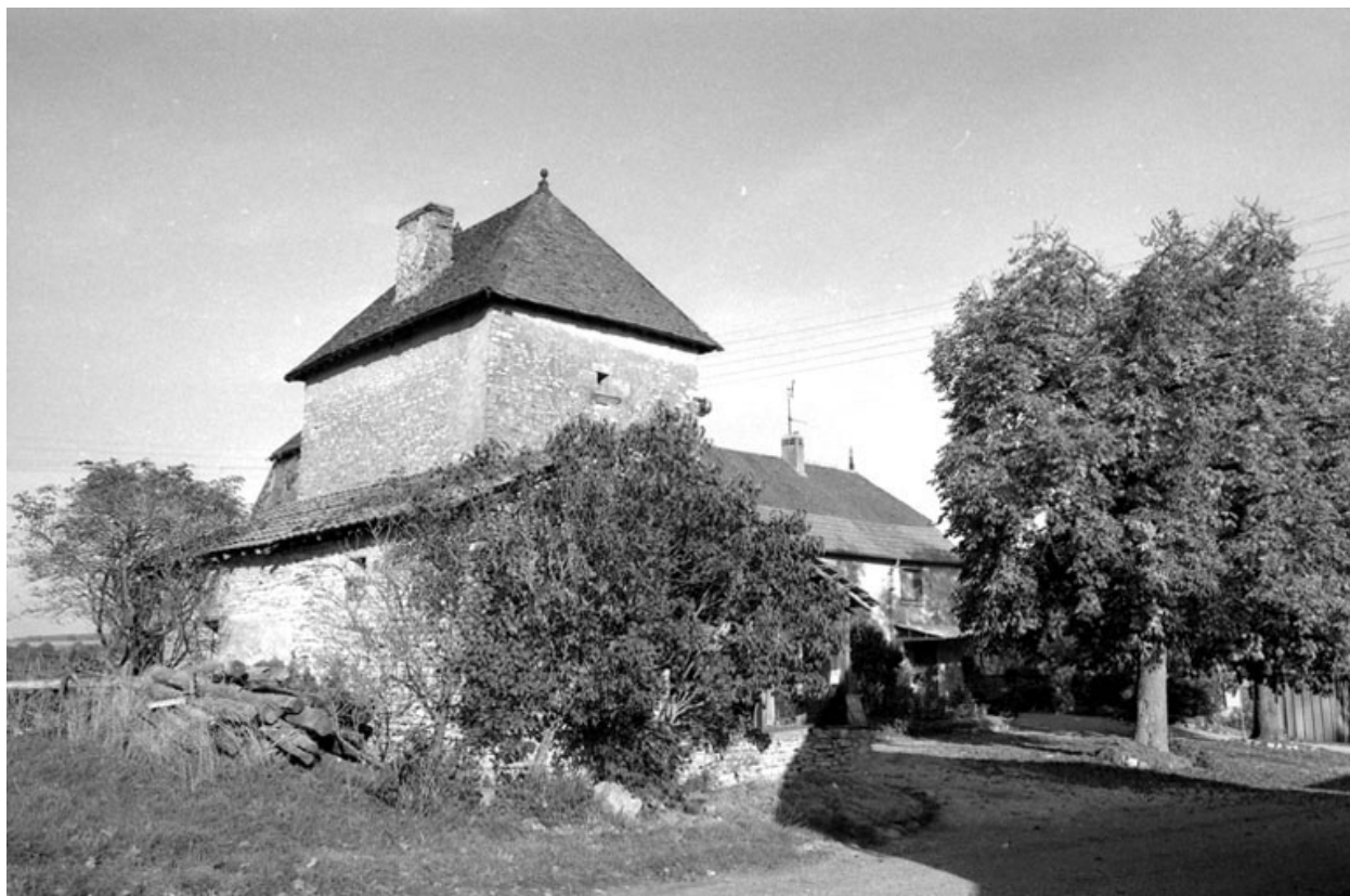
Partie habitation : face latérale gauche.
