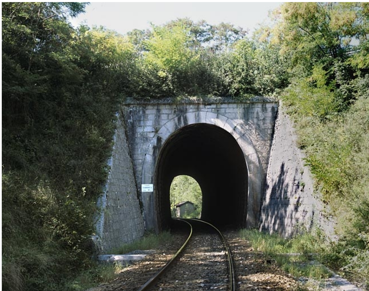
Tunnel d'Arbent 2 : tête côté La Cluse (est).
