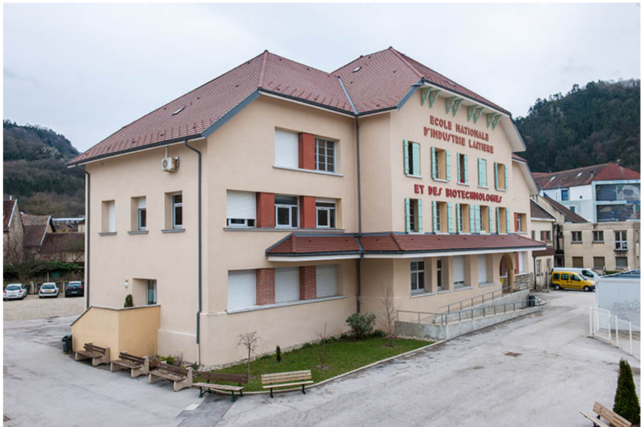
Façade antérieure principale de l'école, angle nord-ouest.
