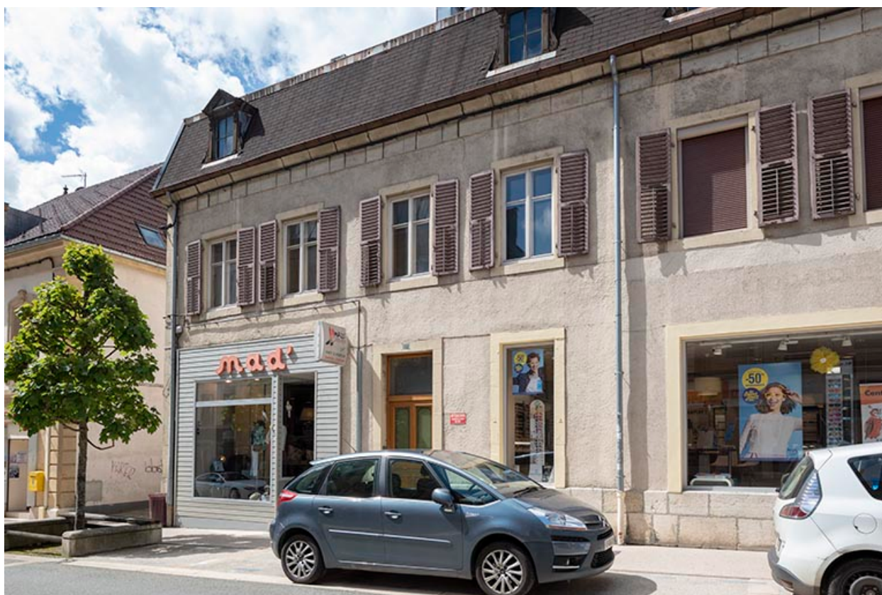
Façade antérieure : partie gauche.
