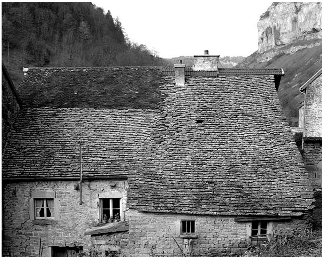
Détail d'une toiture en laves.
