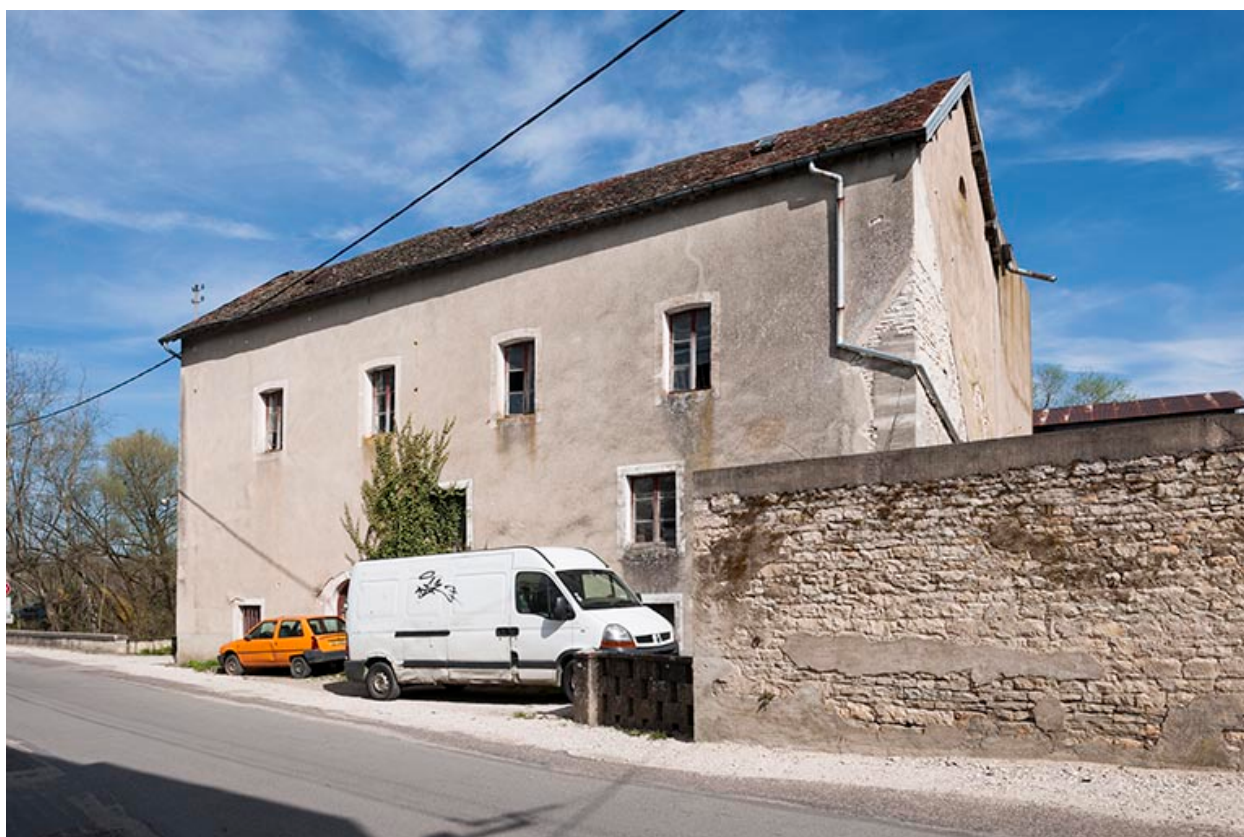
Façade sud de la minoterie.
