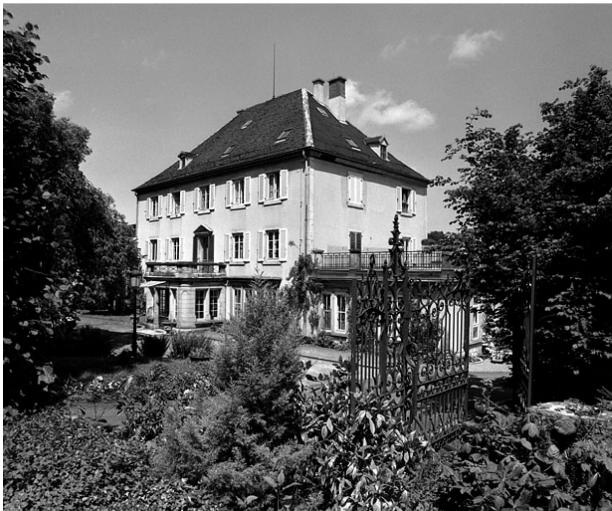
Vue de trois quarts depuis le sud-est.
