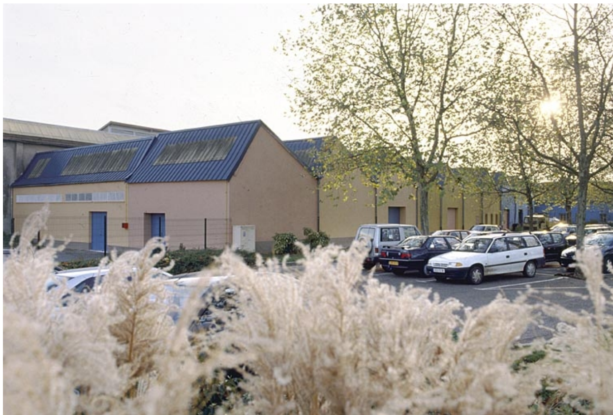
Murs-pignons nord de l'atelier de filature.
