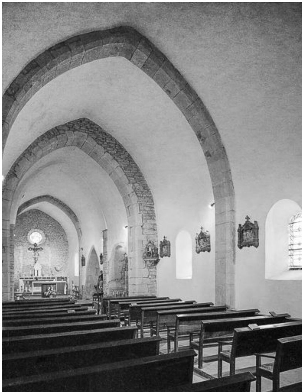
Elévation droite vue depuis l'entrée.
