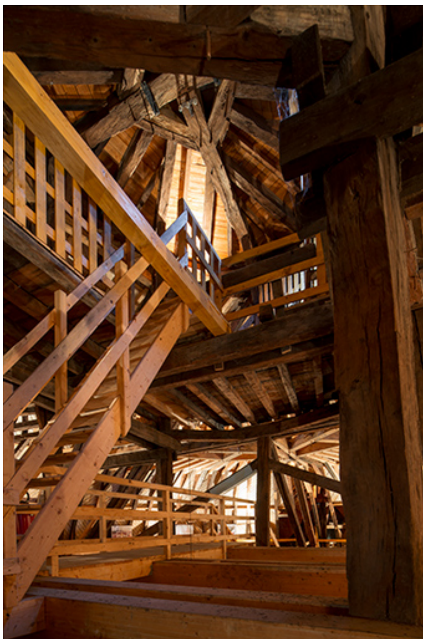
Beffroi du dôme, en contre-plongée, depuis l'est.
