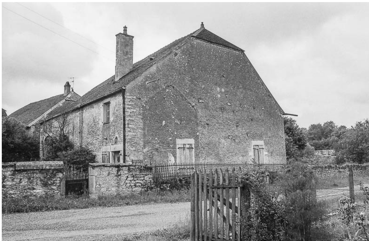
Ferme 4 : bâtiment d'habitation.
