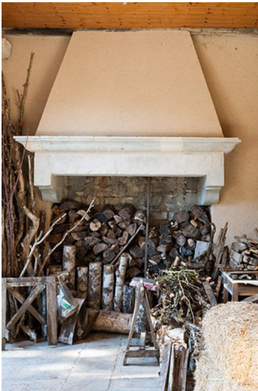
Cheminée située sous le porche
