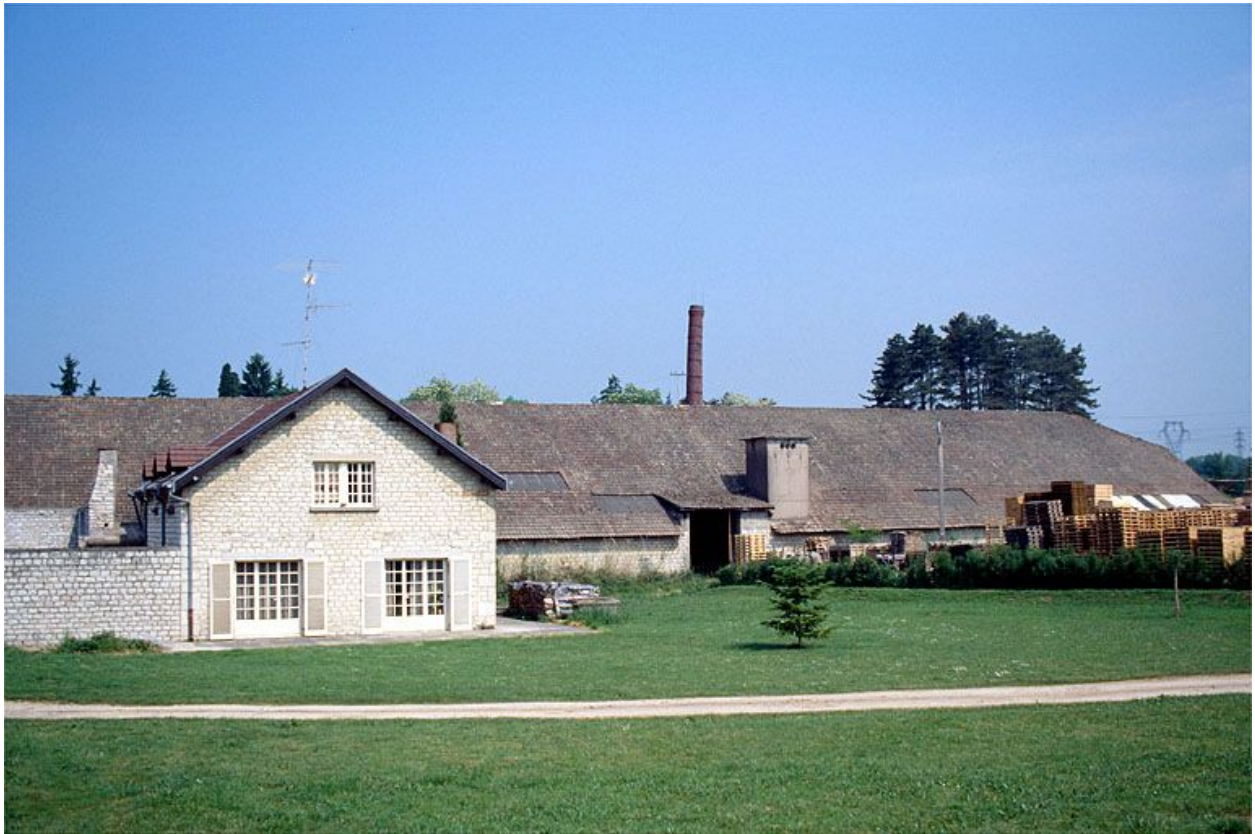
Chaufferie (P) et atelier de fabrication (N) vus de l'est.
