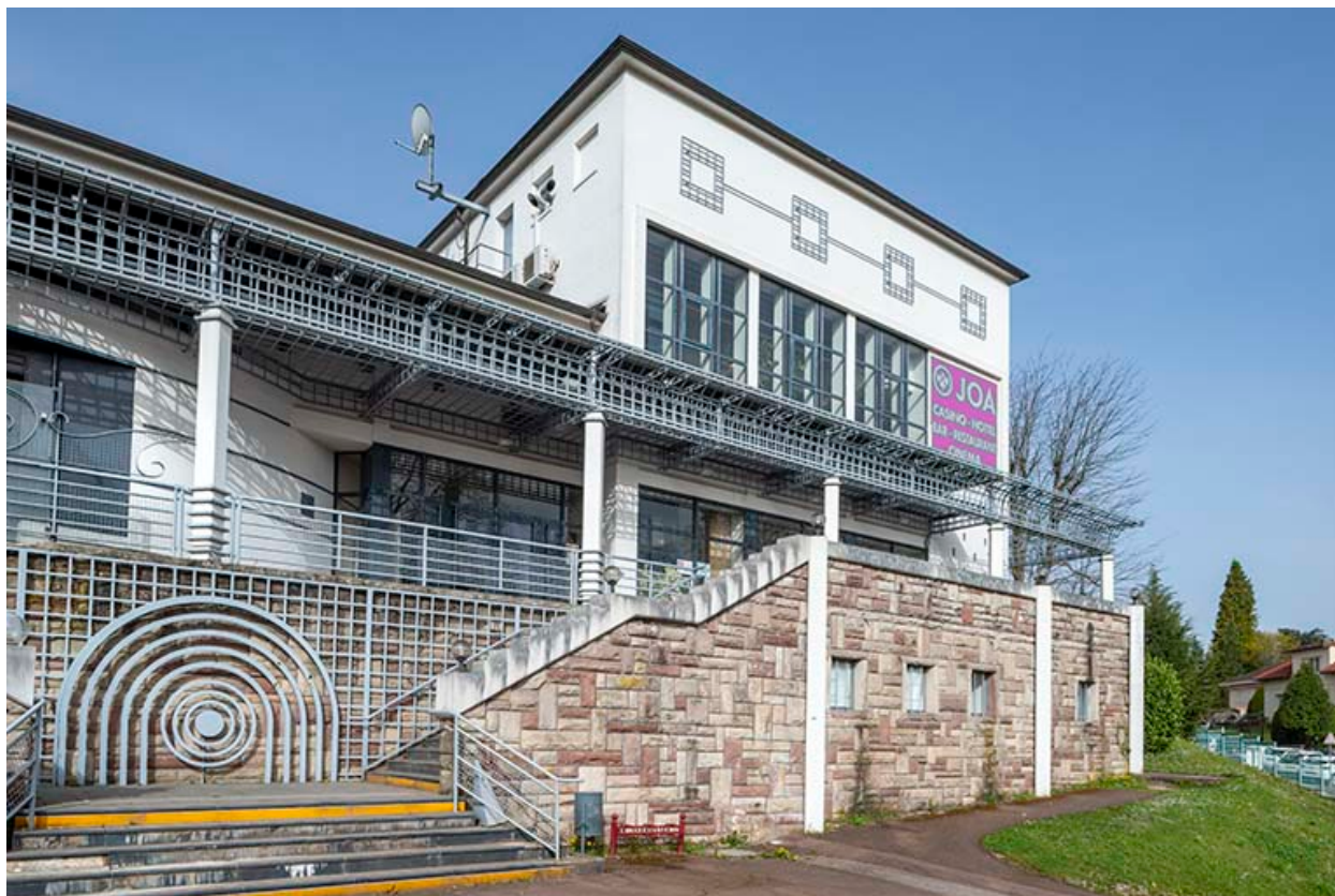
Salle des fêtes, vue depuis le sud-ouest.
